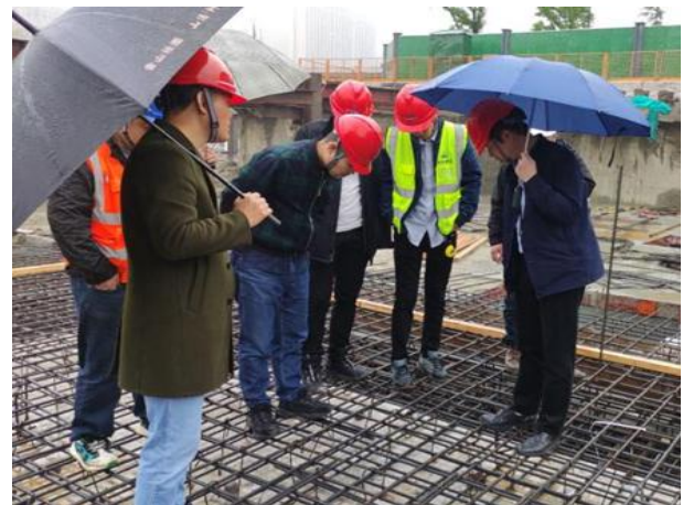
区块底板质检站验收
