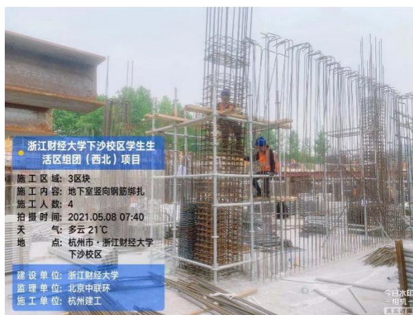
竖向钢筋绑扎
