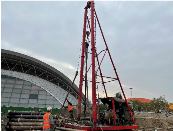
工程桩施工
