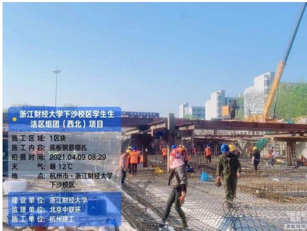
底板钢筋绑扎
