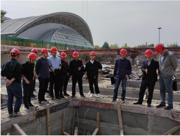
设计单位现场勘察
