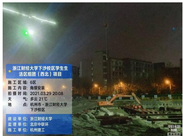
预应力钢支撑安装
