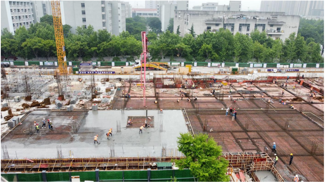
混凝土浇筑
