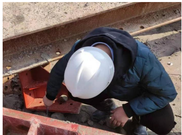
钢支撑进场验收
