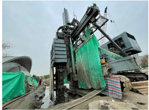
TRD 围护桩施工
