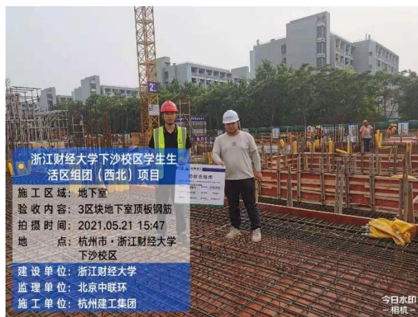
钢筋工程验收
