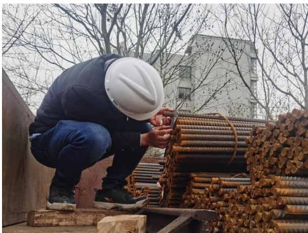
钢筋进场验收
